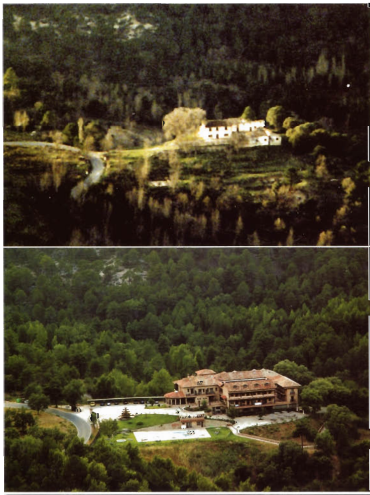
En la fotografía superior, ruinas del cortijo del Coto del Valle, término municipal de Cazorla, Parque Natural Sierras de Cazorla-Segura-Las Villas (Jaén) en 1989 (foto: Dori Ramirez). En la fotografía inferior, indescritible conjunto resultante del relleno del terreno circundante, “rehabilitación” del cortijo y su conversión en hotel. La imagen ha sido tomada este mismo año (foto: Carlos Herrera).
